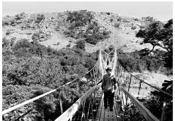
Hängebrücke – Verbindung in einer gespaltenen Gemeinschaft
