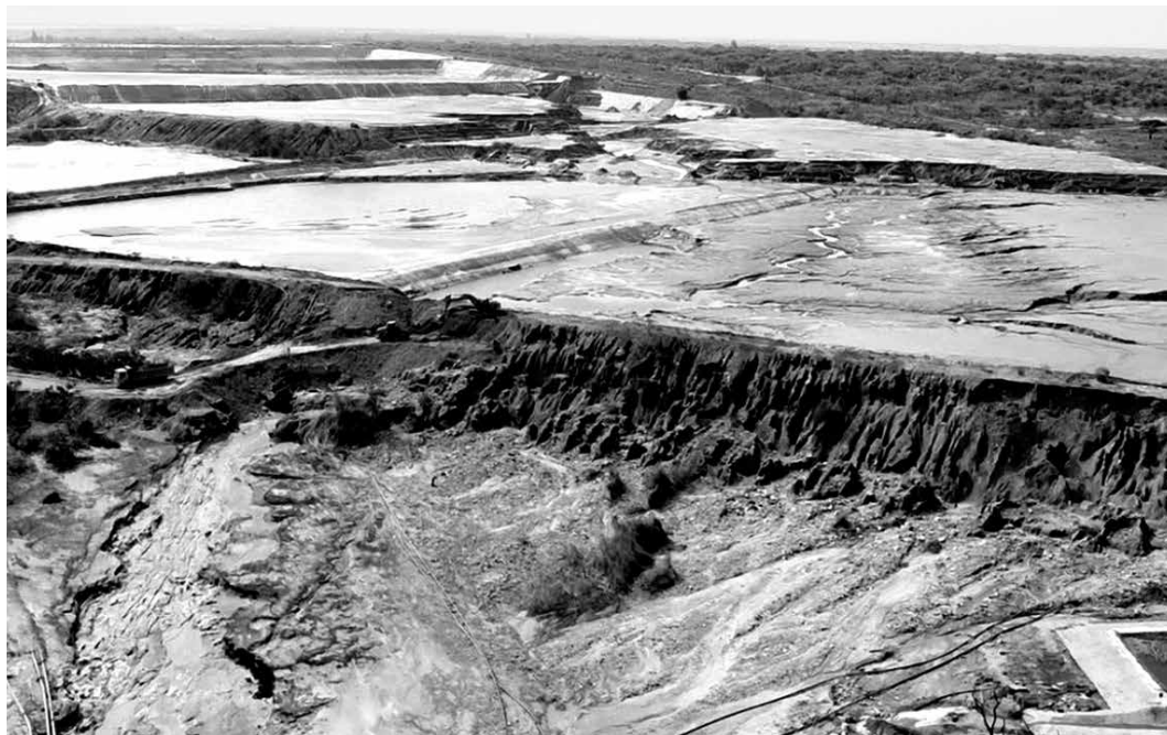
Riesige Umweltzerstörung nach dem Bersten des Rückhaltebeckens.
